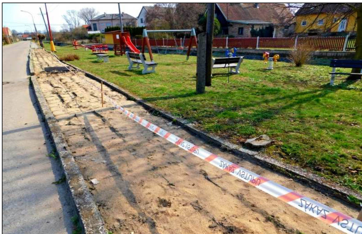
I. etapa opravy chodníku (2019)
